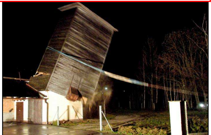
Einsturzgefährdeter Holz Silo nach Sturm Kyrill musste zwangsgefällt werden um höheren Schaden zu verhindern, Kirchdorf. Konnte mit der 20to Seilwinde des Kran durchgeführt werden.
