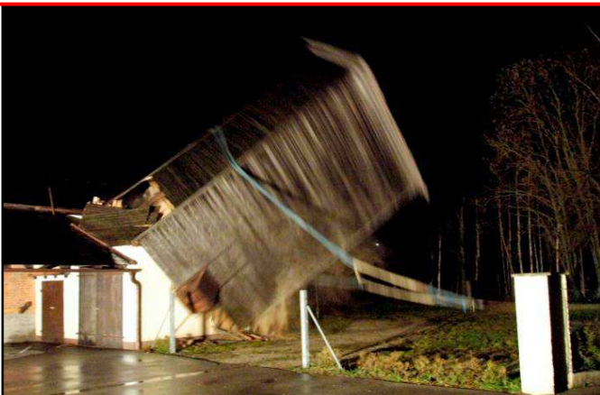
Einsturzgefährdeter Holz Silo nach Sturm Kyrill musste zwangsgefällt werden um höheren Schaden zu verhindern, Kirchdorf. Konnte mit der 20to Seilwinde des Kran durchgeführt werden.
