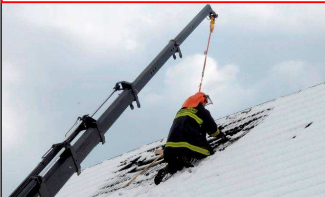
Abdichten eines Daches nach Sturm
