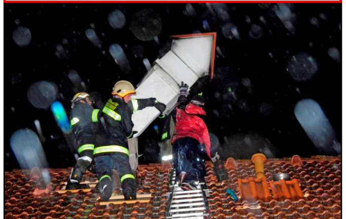
Absturzgefährdeter Rauchfang nach Sturm
