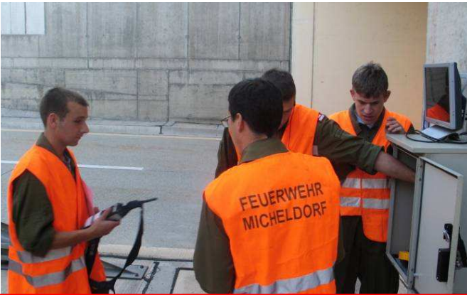
Nischencheck Autobahntunnel A9
